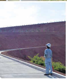
●ドローンによる測量
