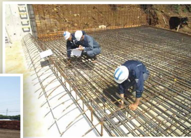
●ため池洪水吐の配筋検査
