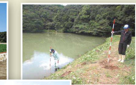
●ため池の点検調査
