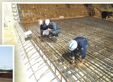
●ため池洪水吐の配筋検査
