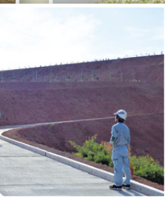
●ドローンによる測量
