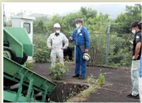
●土地改良施設の機能診断
