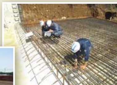
●ため池洪水吐の配筋検査
