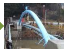
下岳水管橋 (着工後)
