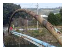
下岳水管橋 (着工前)
