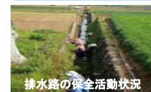
排水路の保全活動状況
