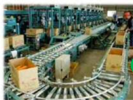
にんじん洗浄選別施設
