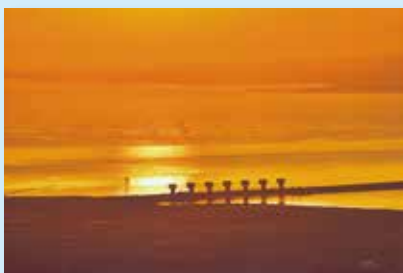
陽に染まる排水樋門 ／ 江口 徳郎（大村市）
