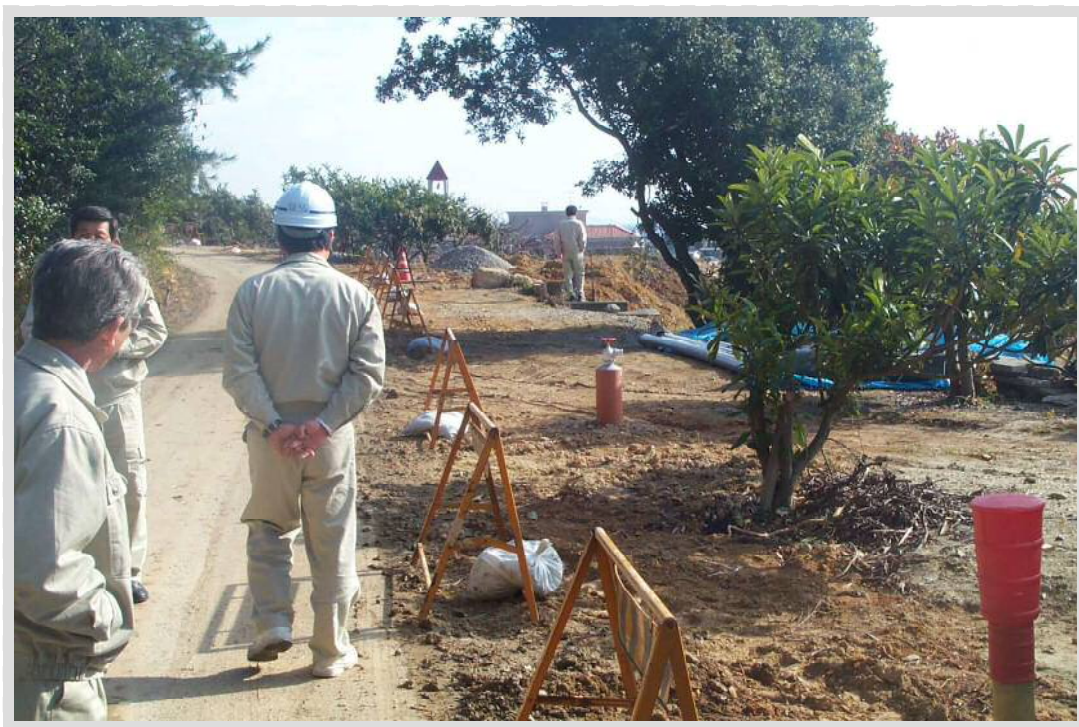
パイプラインの補修作業
