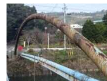
下岳水管橋 (着工前)
