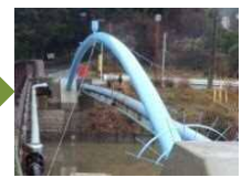
下岳水管橋 (着工後)
