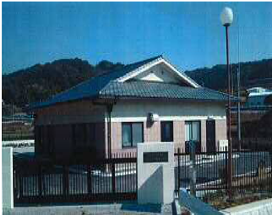
農業集落排水処理施設（外観）
