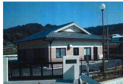
農業集落排水処理施設（外観）
