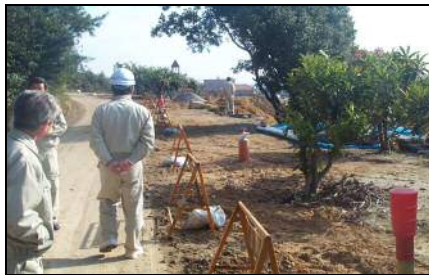
パイプラインの補修作業
