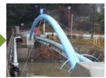
下岳水管橋 (着工後)
