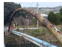
下岳水管橋 (着工前)
